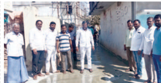
తొమ్మిదవ వార్డులో సిమెంట్ రోడ్ నిర్మాణ పనులను ప్రారంభిస్తున్న సర్పంచ్
